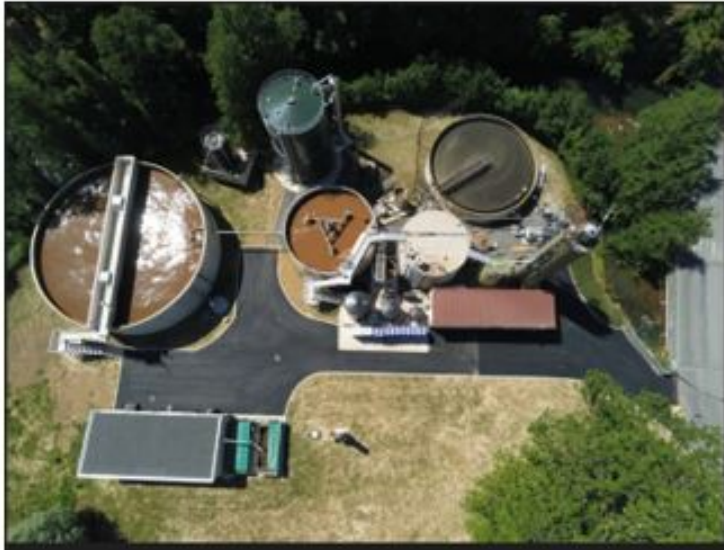
Extension de station avec méthanisation (papeterie)
